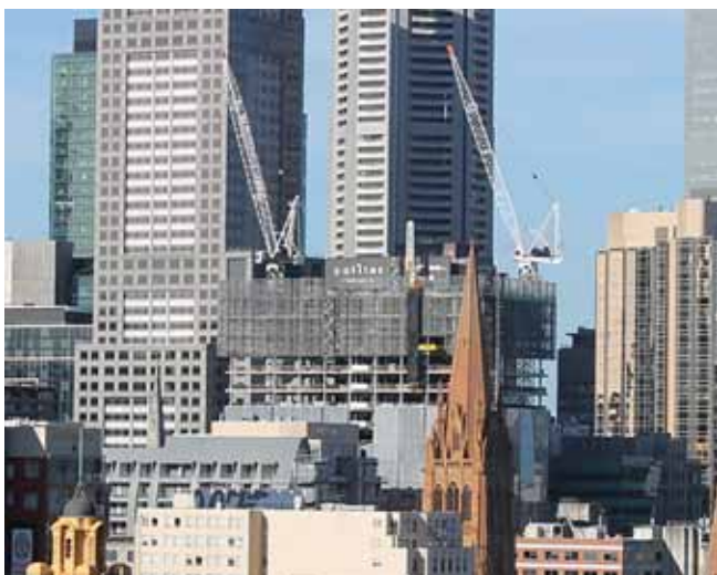
ساختمان ۱۷۱ خیابان کالینز، کرتوال اصلی به همراه شیشه‌های DGU نصب شده
